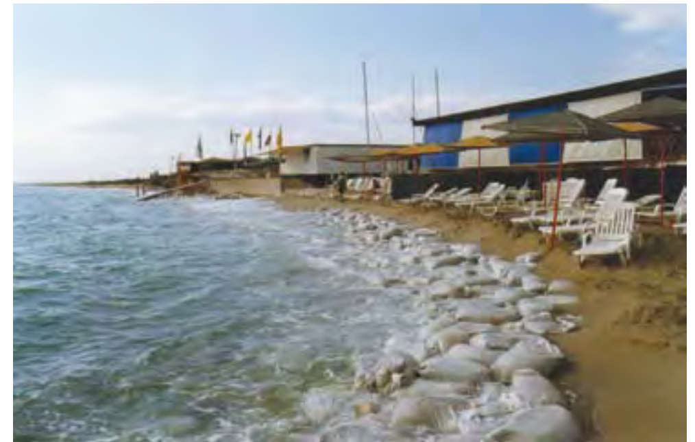
Fig. 8.6 - Vistosi fenomeni di arretramento interessano numerose spiagge del Salento. Una delle unità più colpite è quella di Marina di Ugento, attualmente difesa da una opera aderente.
